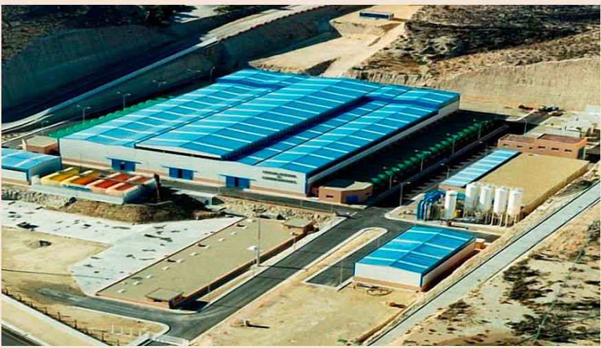
Planta desaladora construida por Inima en Carboneras (Almería).
